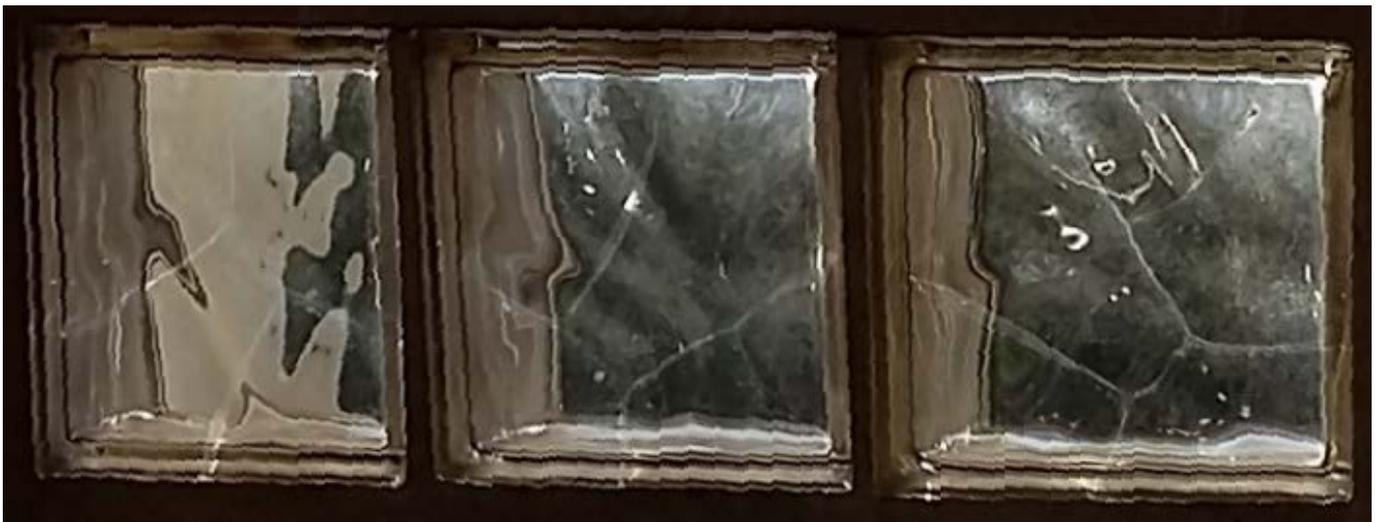
Il montre bien à quel point la déformation de lumières est ample et tortueuse, et causée par la surface ondulée et irrégulière de la brique
