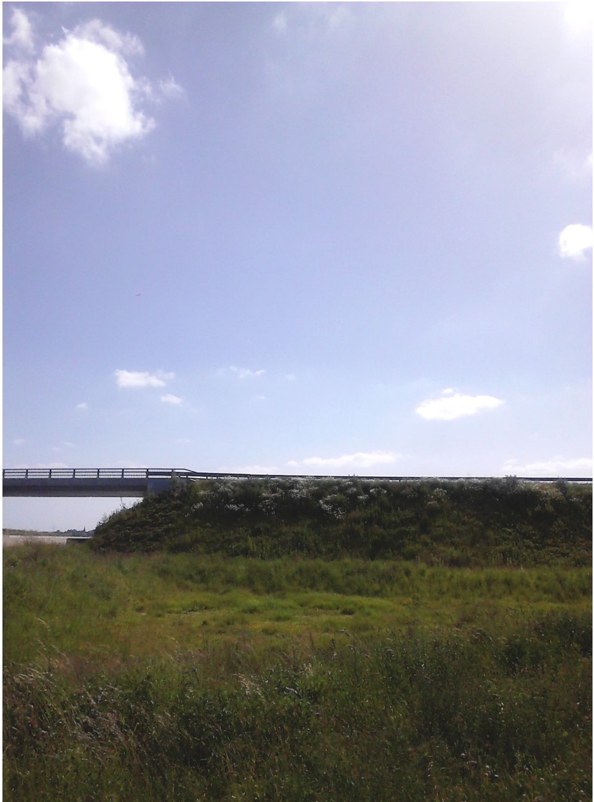
Emplacement à la verticale du phénomène observé
