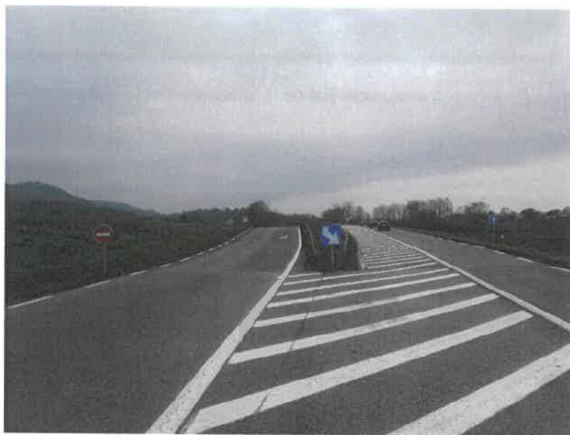
Vue de la Route Départementale 1083 sens LONS LE SAUNIER -BOURG EN BRESSE ( direction Sud) (sens de circulation du témoin)
